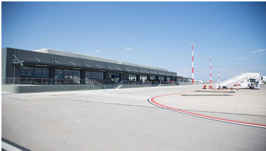
Εικόνα 20: Αερολιμένας PVK, ελεγχόμενη περιοχή αεροσκαφών.
