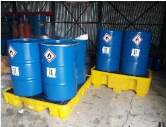
Εικόνα 33: Βαρέλια για την αποθήκευση χρησιμοποιημένων ελαίων σε εσωτερικό χώρο. Τα χρησιμοποιημένα έλαια αποστέλλονται προς ανακύκλωση δια μέσω του αντίστοιχου Συστήματος Εναλλακτικής Διαχείρισης.
