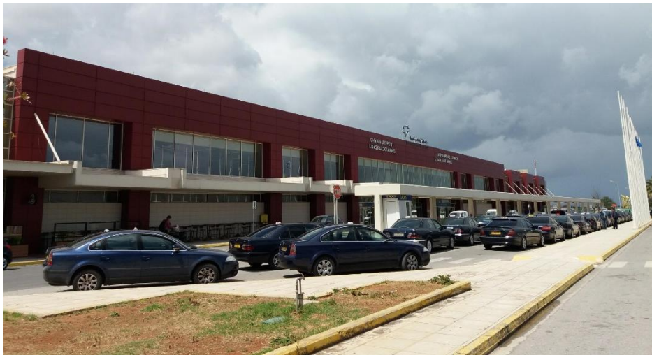
Εικόνα 9: Πρόσοψη τερματικού σταθμού από την πλευρά της πόλης..
