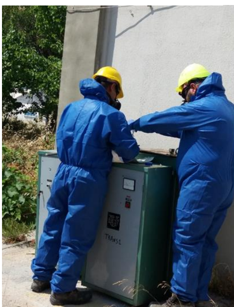
Εικόνα 15: Δειγματοληψία ηλεκτρικής συσκευής για PCB, από αδειοδοτημένη εταιρεία, στον αερολιμένα MJT.
