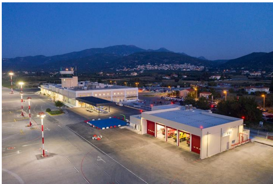
Εικόνα 6: Τοποθεσία αερολιμένα SMI - https://www.smi-airport.gr/en
