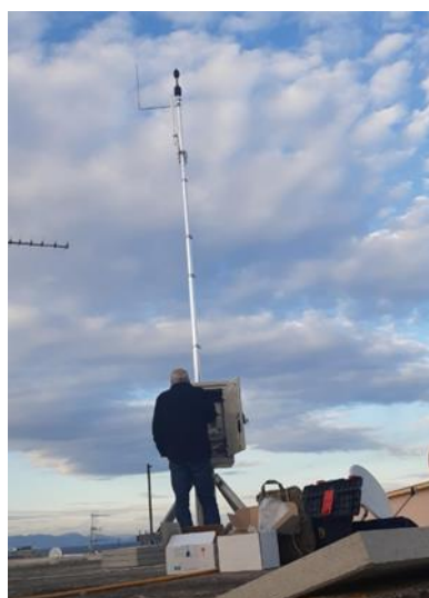
Εικόνα 12: Σταθμός παρακολούθησης θορύβου (MP01) στη Ρόδο.
