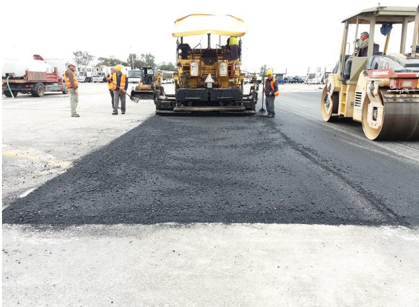
Επισκευές στο οδόστρωμα της πίστας
