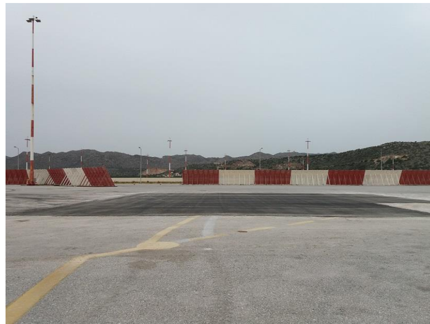
Επισκευές στο οδόστρωμα της πίστας
