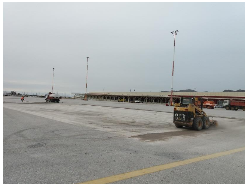
Επισκευές στο οδόστρωμα της πίστας
