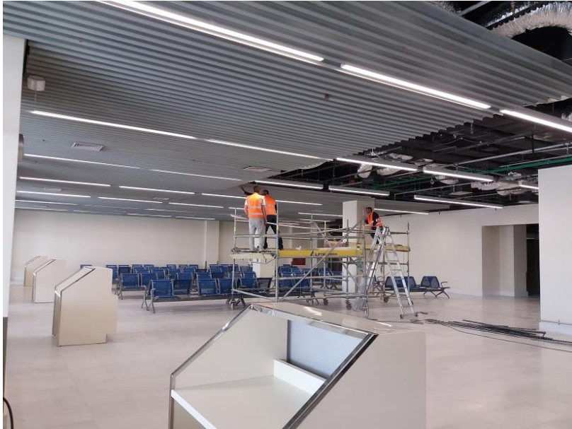
Νέος φωτισμός και τοποθέτηση της ψευδοροφής στις Αίθουσες Αναχωρήσεων
