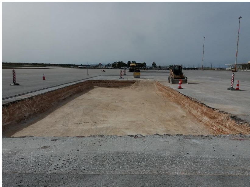
Επισκευές στο οδόστρωμα της πίστας
