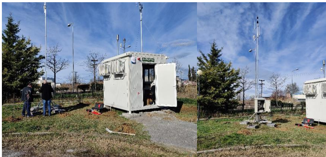
Εικόνα 13: Σταθμός παρακολούθησης θορύβου στον αερολιμένα Θεσσαλονίκης (SKG) (MP01).
