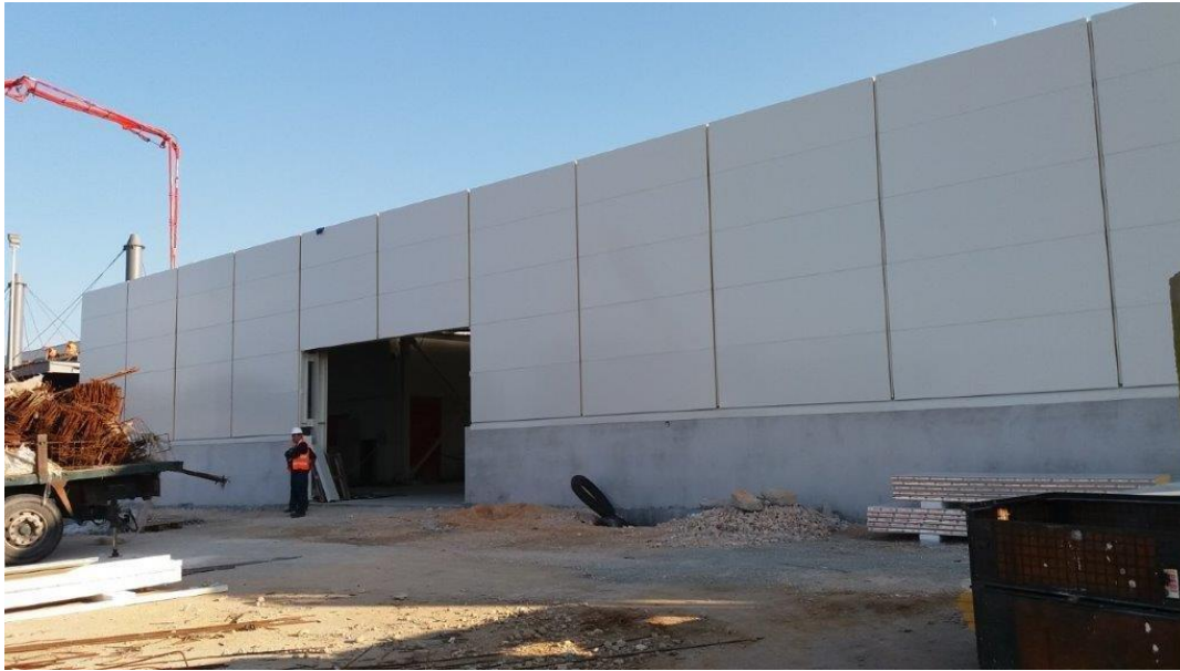
Νέο κτίριο BHS
