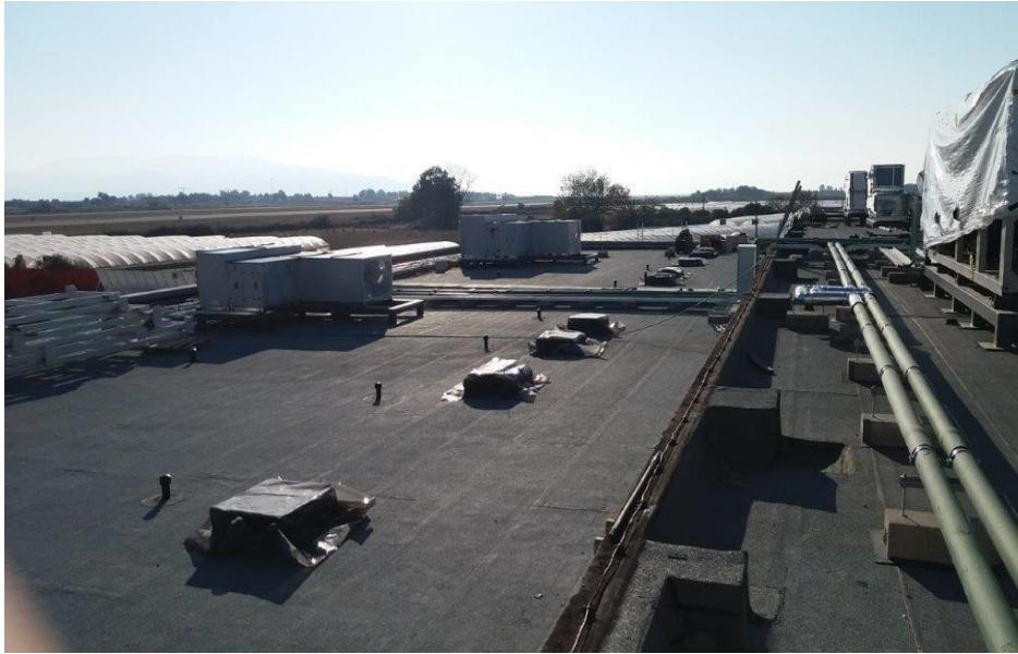
Εγκατάσταση νέων κλιματιστικών μονάδων
