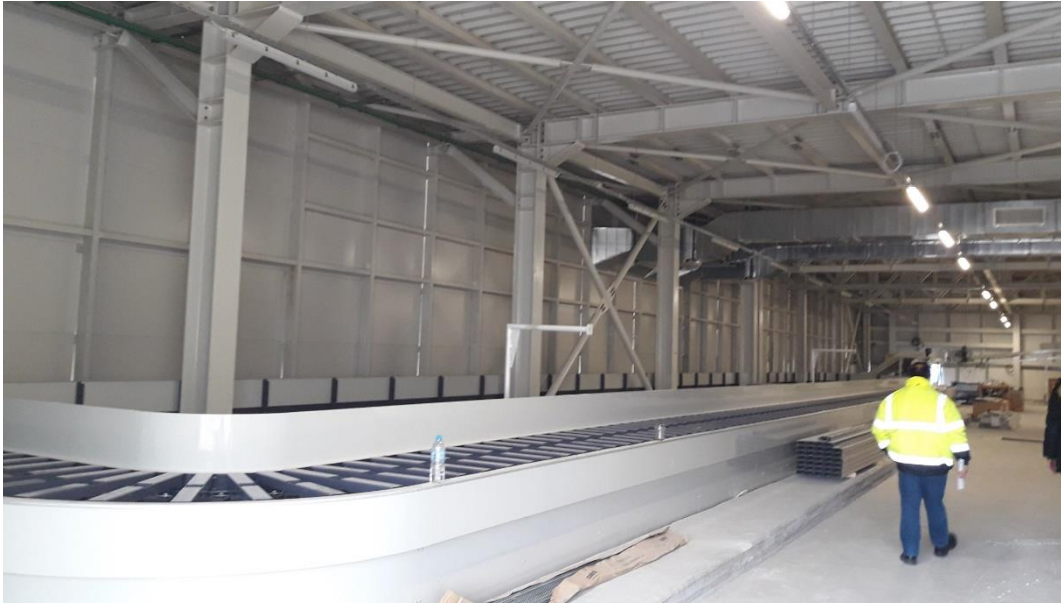
Νέο κτίριο και σύστημα BHS
