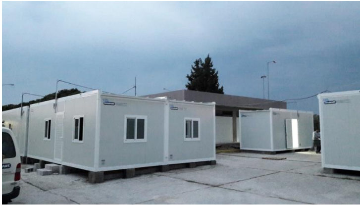
Τοποθέτηση κοντέινερς για τους Πυροσβέστες / Installation of containers for the RFF staff
