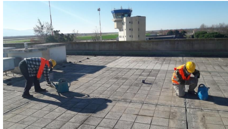
Επισκευή μόνωσης δώματος / Roof insulation repairs
