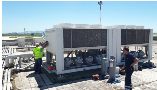
Επισκευές των μηχανημάτων κλιματισμού / HVAC repairs
