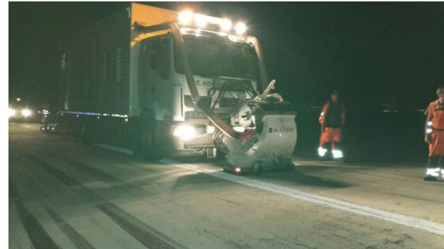
Απογόμωση / Rubber removal
