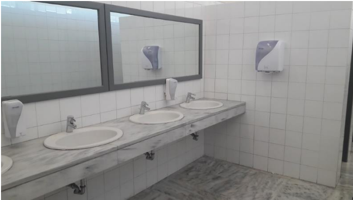
Επισκευή-Ανακαίνιση Τουαλετών/ Toilet Refurbishment-Repairs
