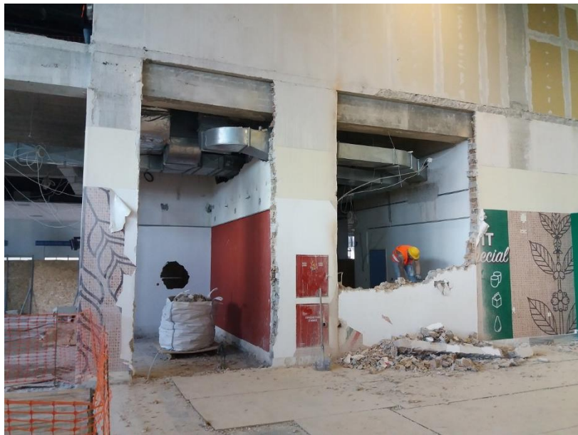
Καθαιρέσεις ισογείου – Ground Floor Demolitions
