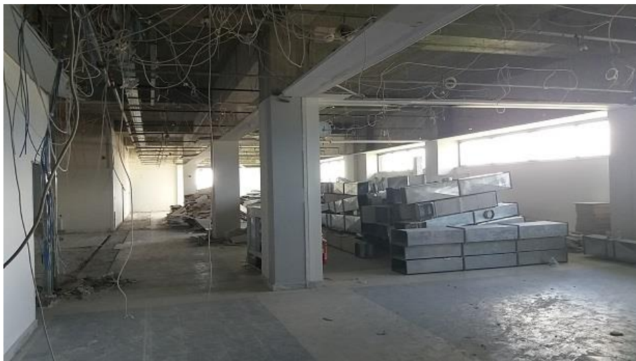
Καθαιρέσεις χώρων υγιεινής ισογείου– Demolition of WC in ground floor
