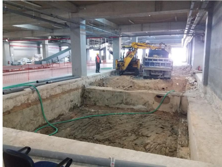
Εκσκαφή θεμελίωσης επέκτασης παταριού – Foundation excavation for mezzanine extension
