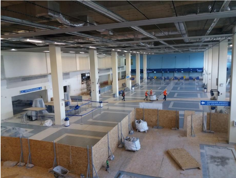
Εργασίες στην Αίθουσα Αναχωρήσεων – Works in Departures Hall
