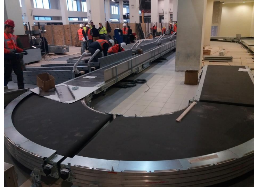
Τοποθέτηση των νέων ιμάντων του BHS - Setting-up the new BHS conveyors
