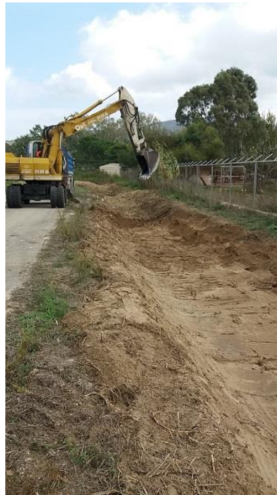
Καθαρισμός περιμετρικών τάφρων – Cleaning of ditches
