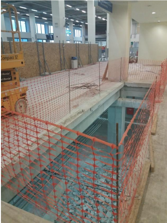
Άνοιγμα οπής στην πλάκα ισογείου – Slab opening on ground floor
